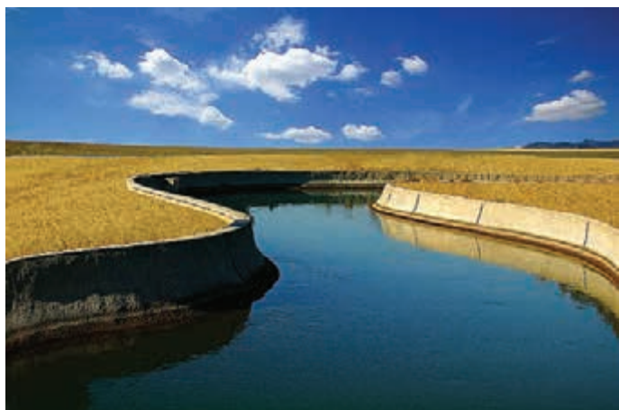
Canal de Marseille © Société des Eaux de Marseille
